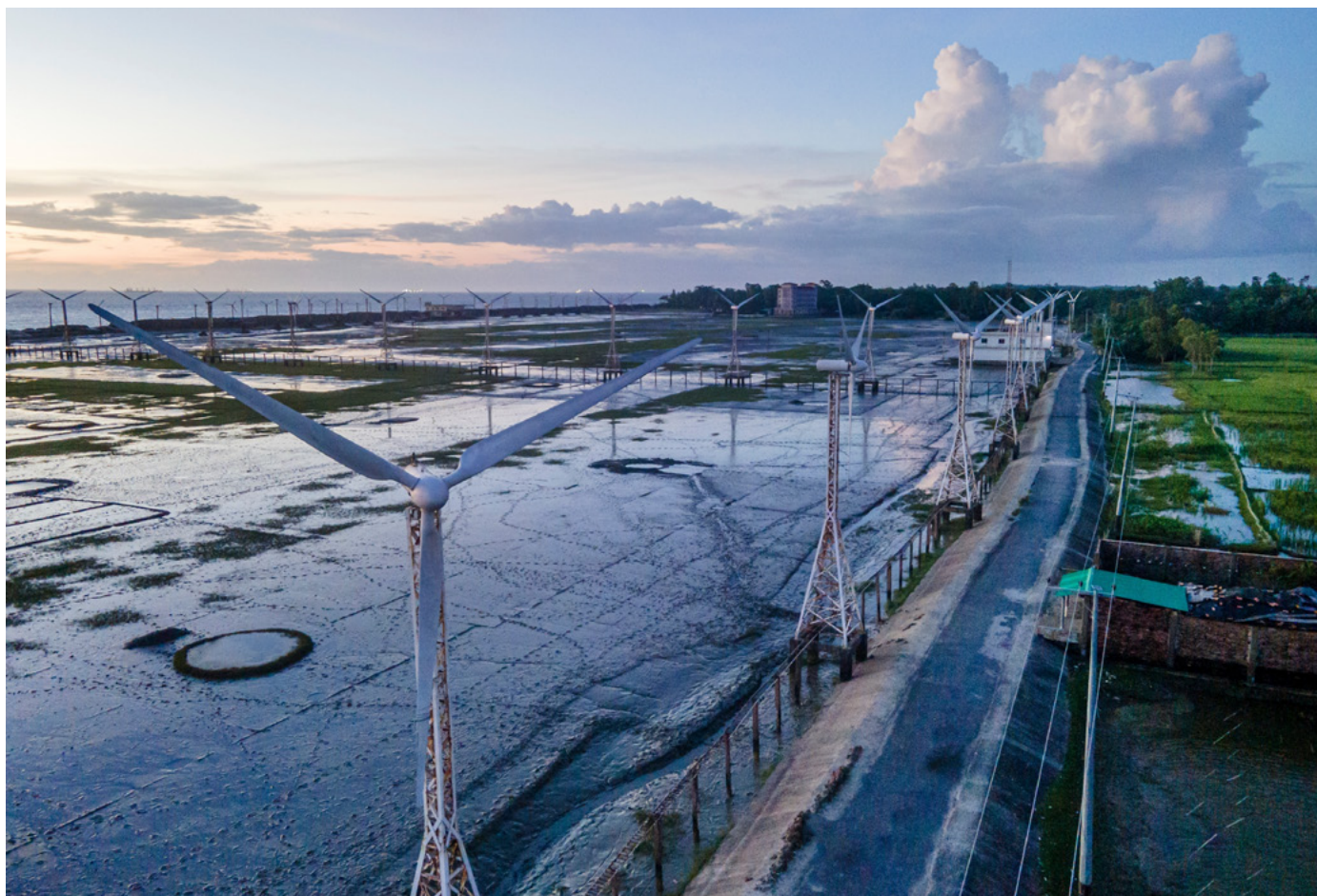
Photo: Vue de la centrale éolienne de Kutubdia, Bangladesh
